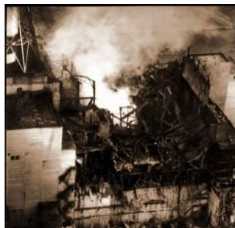
Ад. Вход. Видъ сверху
