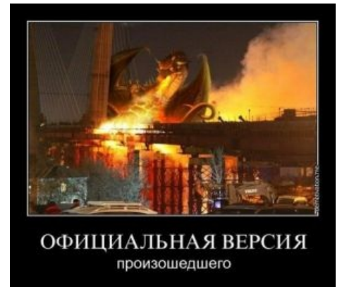
Возгорание деревянной опалубки на строящемся мосту через бухту Золотой Рог. Владивосток.
