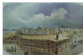
Возведение стен и облицовка форта «Павел I»
