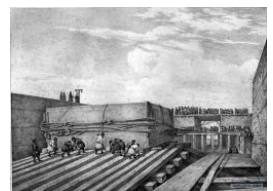
Переворот пьедестала необработанной нижней стороной кверху для дальнейшей обтёски
