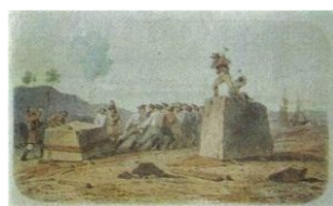
Одна бригада грузчиков доставляла из карьера на строительную площадку около восьми блоков в день.
