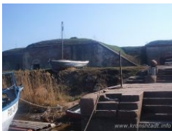
Причал форта Константин, лестница сложена из монолитных кусков гранита с вырезанными ступенями
