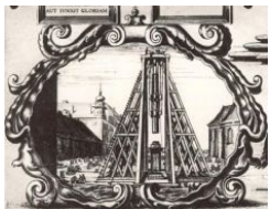
Подъем и установка колонны обелиска Сигизмунда, гравюра 1646 год
