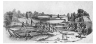
Транспортировка на катках
