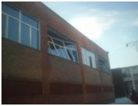
Челябинск, школа №51, окна спортзала
