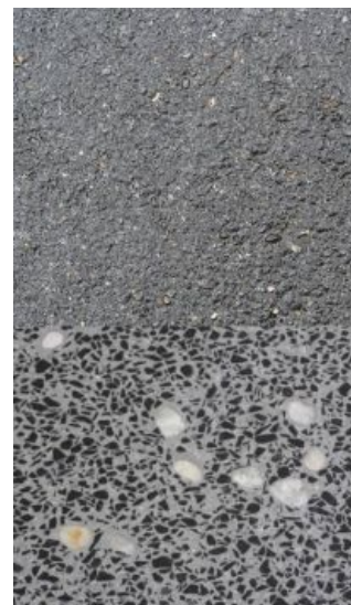
Разница между фактурой просто залитого (вверху) и шлифованного бетона (внизу)
