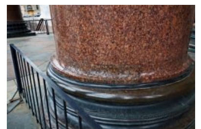
Реставрационную заплатку подбирали как можно ближе по цвету и структуре гранита колонны
