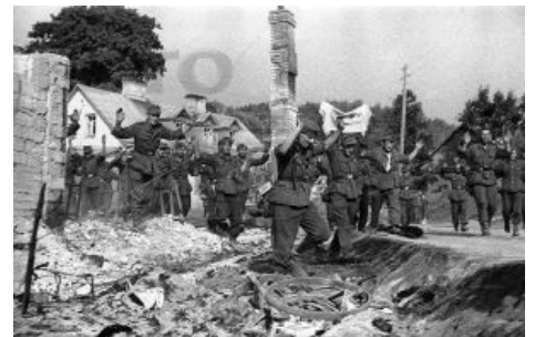
Сдались. Котёл работает!
