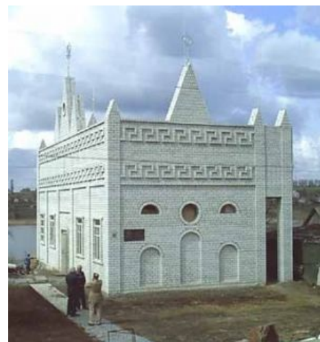
Трансформаторная будка Святыня РУНВіри
